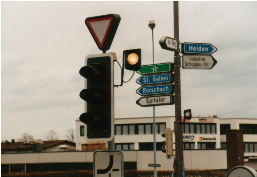
Abb. 1: Einfeldriger Signalgeber mit weißem Leuchtfeld in St. Gallen / Rosenbergstraße
